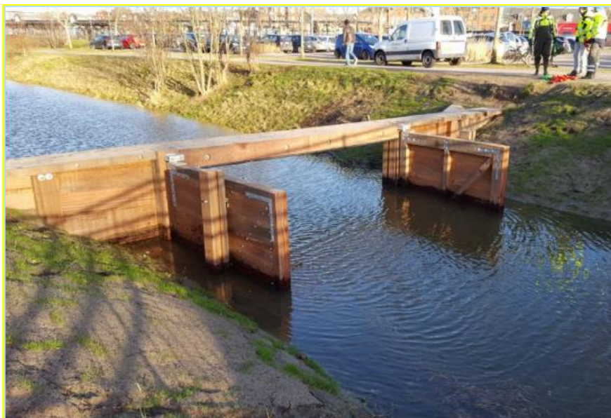
Figur 4-8: Eksempel på sluse set forfra (opstrøms) med åbne porte. Billede fra Ref. [14]
