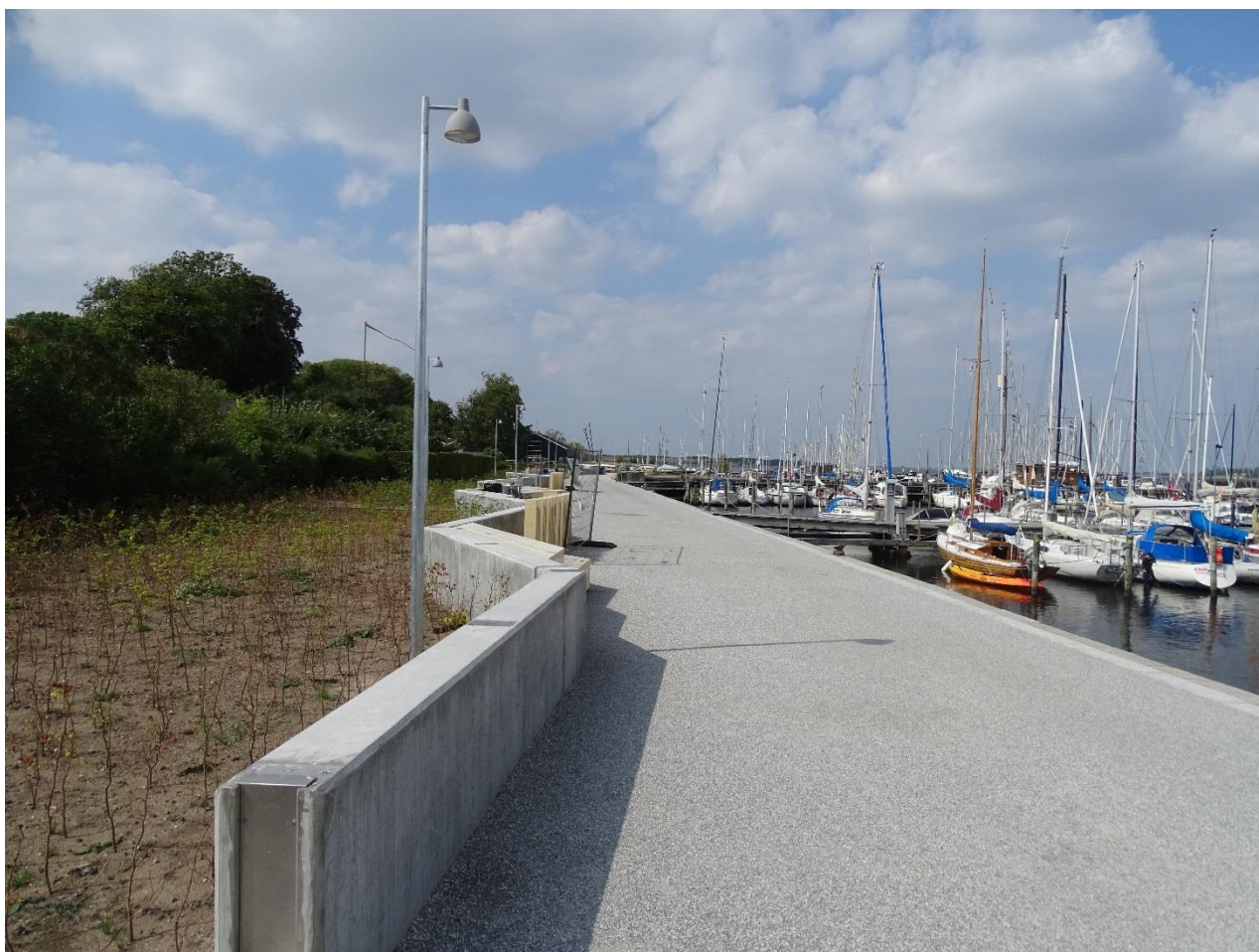
Figur 4-20: Højvandsmur i beton, eksempel fra Roskilde
