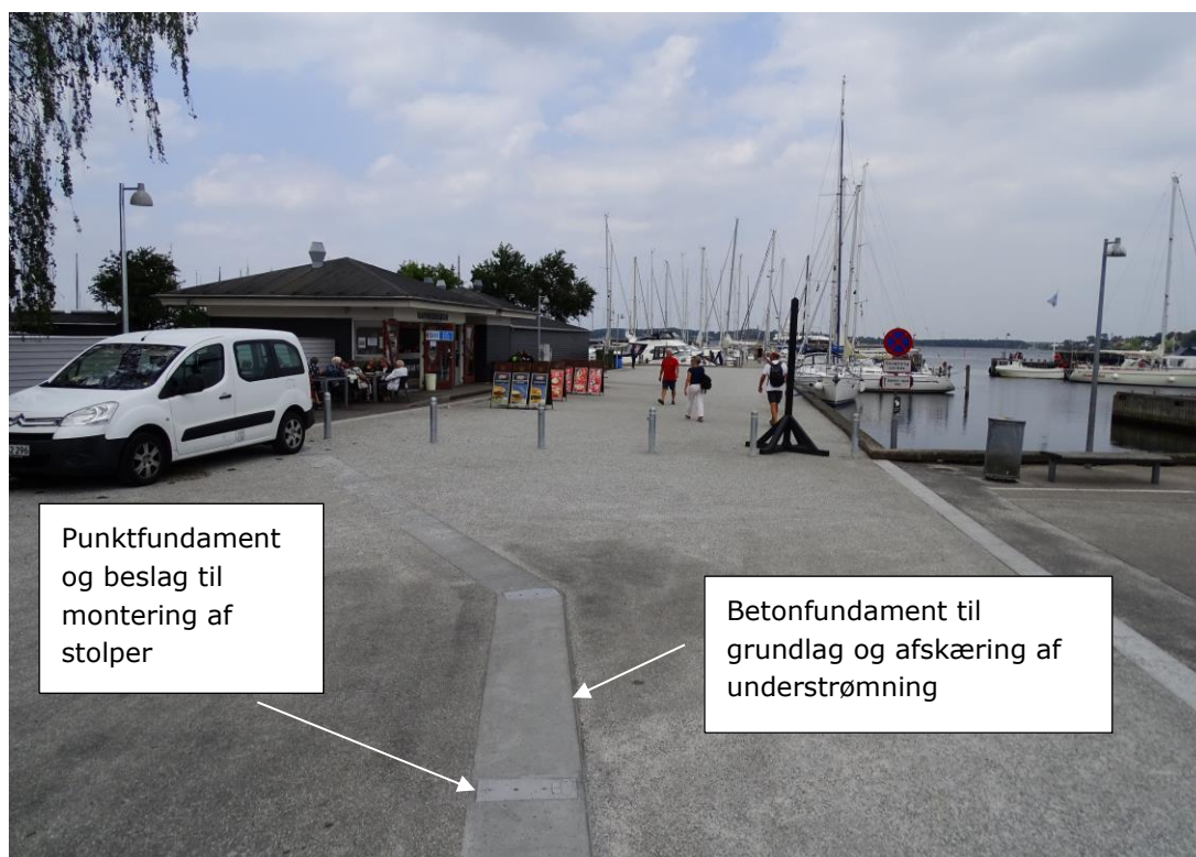
Figur 4-15: Eksempel på synlig del af fundament til demonterbar højvandsmur fra Roskilde Inderfjord
