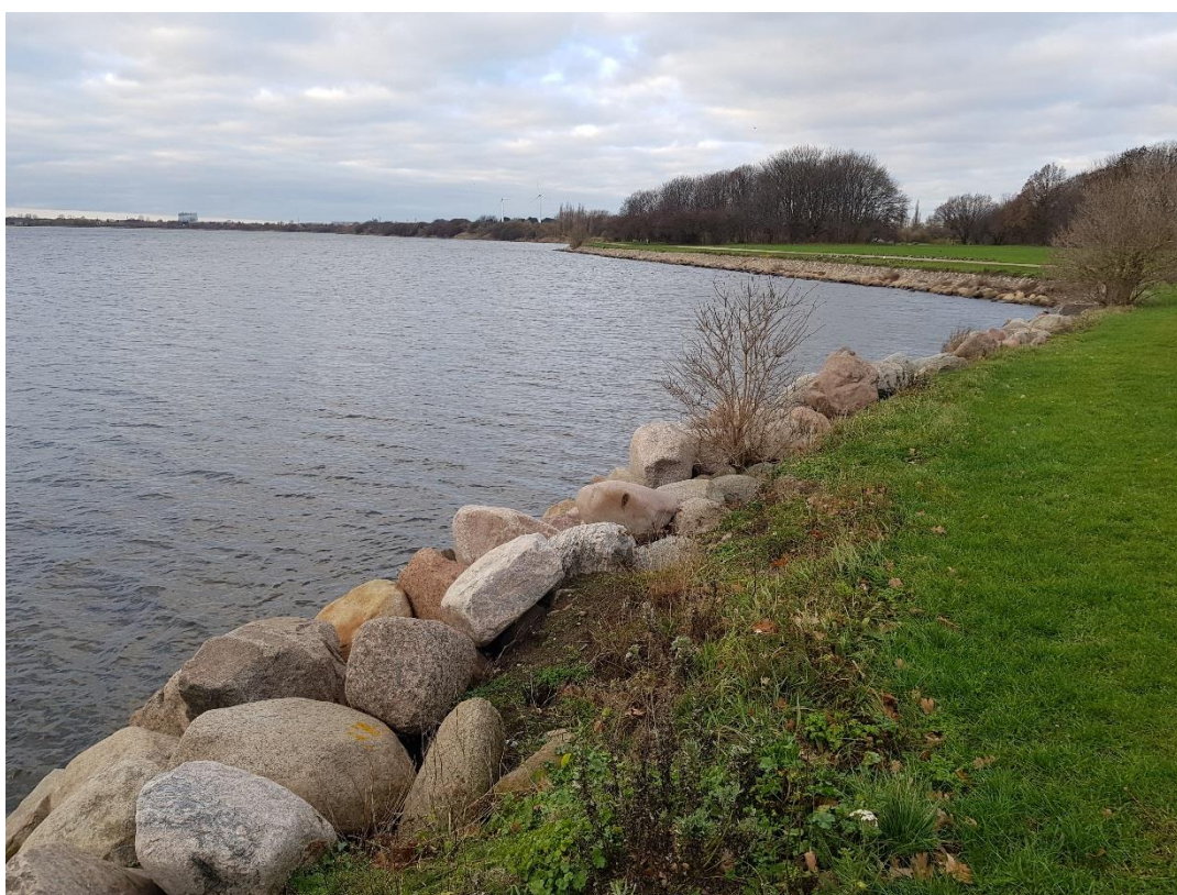
Figur 4-6: Eksempel på stenkastningsskråning fra Valbyparken. Der skal gøres opmærksom på, at størrelsen af de sten der er foreslået til Karlstrup Mosebæk, er væsentligt mindre end de viste sten.
