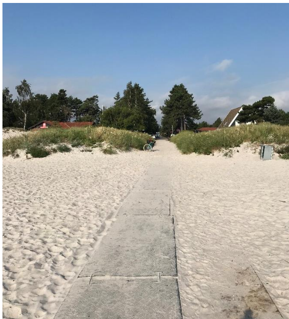
Figur 2-3: Adgangssti fra parkeringsareal til badebro, stien er beklædt med træplanke og gummimåtte belægning.
