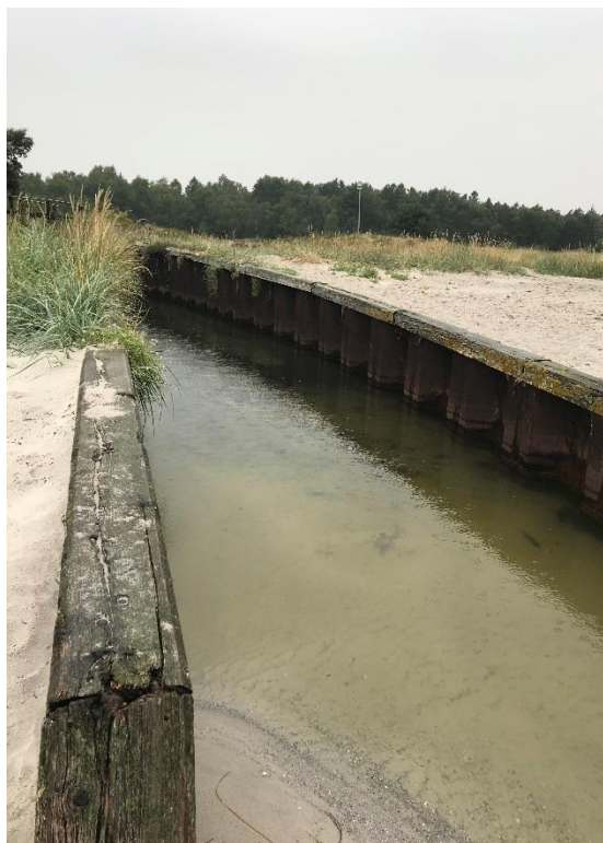
Figur 2-7: Spunstrug ved udløb af Karlstrup Mosebæk igennem strandarealet. Spunsen er afsluttet med træhammer.
