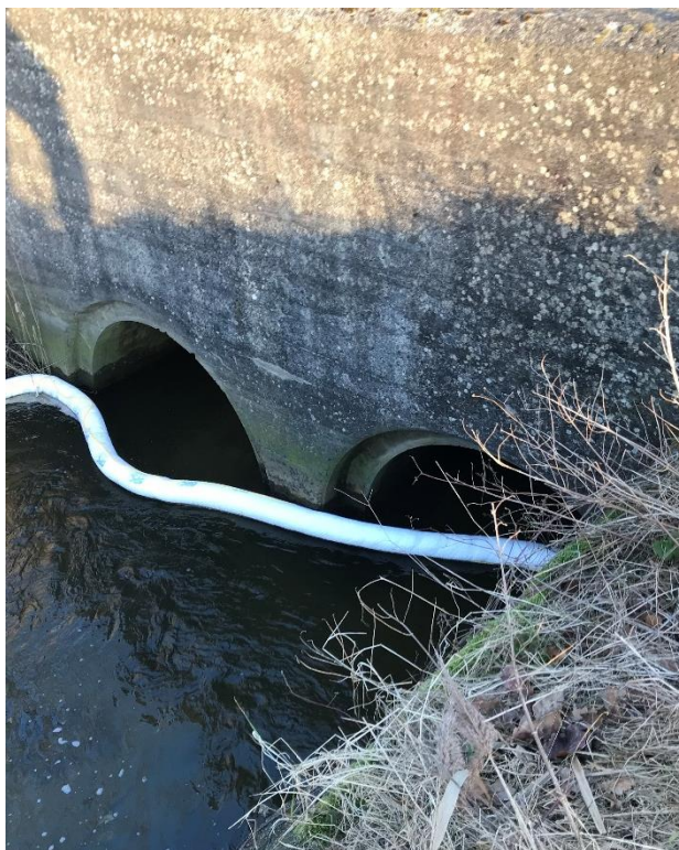
Figur 2-6: Rørunderføring under Karlstrup Strandvej set fra opstrøms side (vest).
